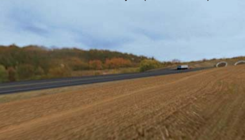
Tunel Radejčín (stavba 0805/F)
