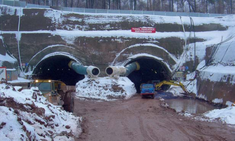
Tunel Panenská (stavba 0807/IIG) – rok 2004
