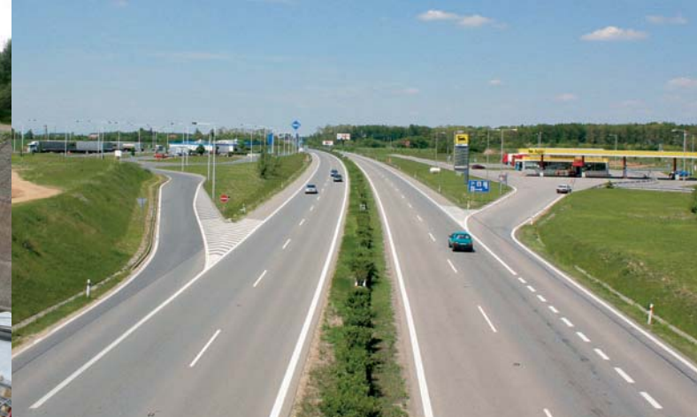
Čerpací stanice (stavba 0801)
