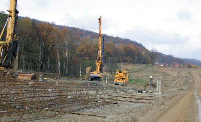
Most Knínice (stavba 0807/II E) – rok 2004
