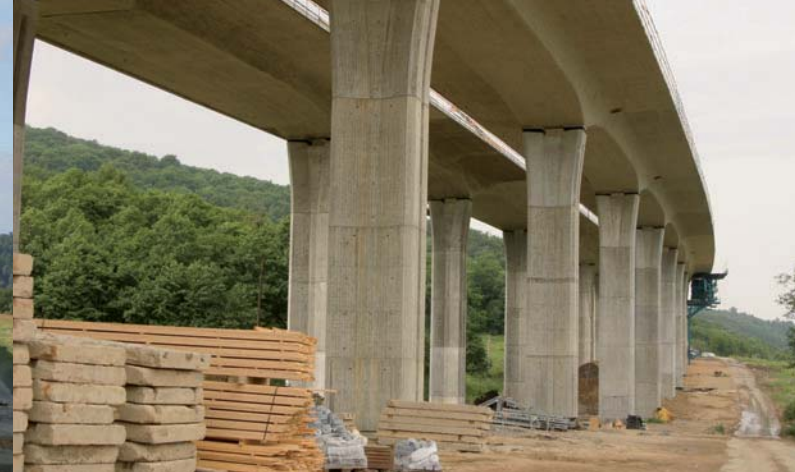
Most Knínice (stavba 0807/II E) – rok 2006
