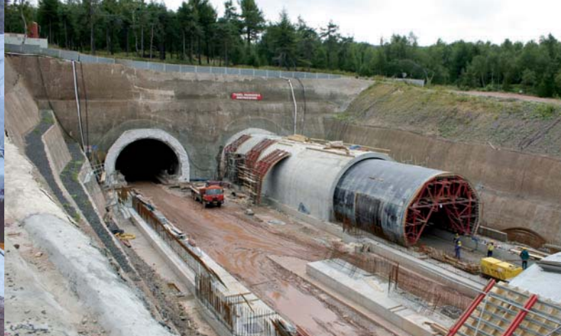
Tunel Panenská (stavba 0807/IIG) – rok 2005
