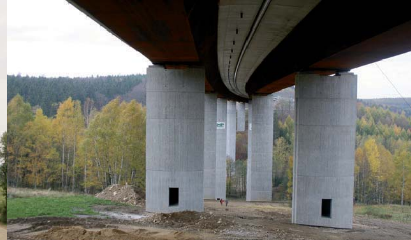
Hraniční most (stavba 0807/II K)
