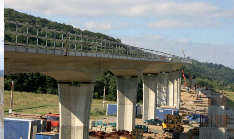
Most Knínice (stavba 0807/II E) – rok 2005
