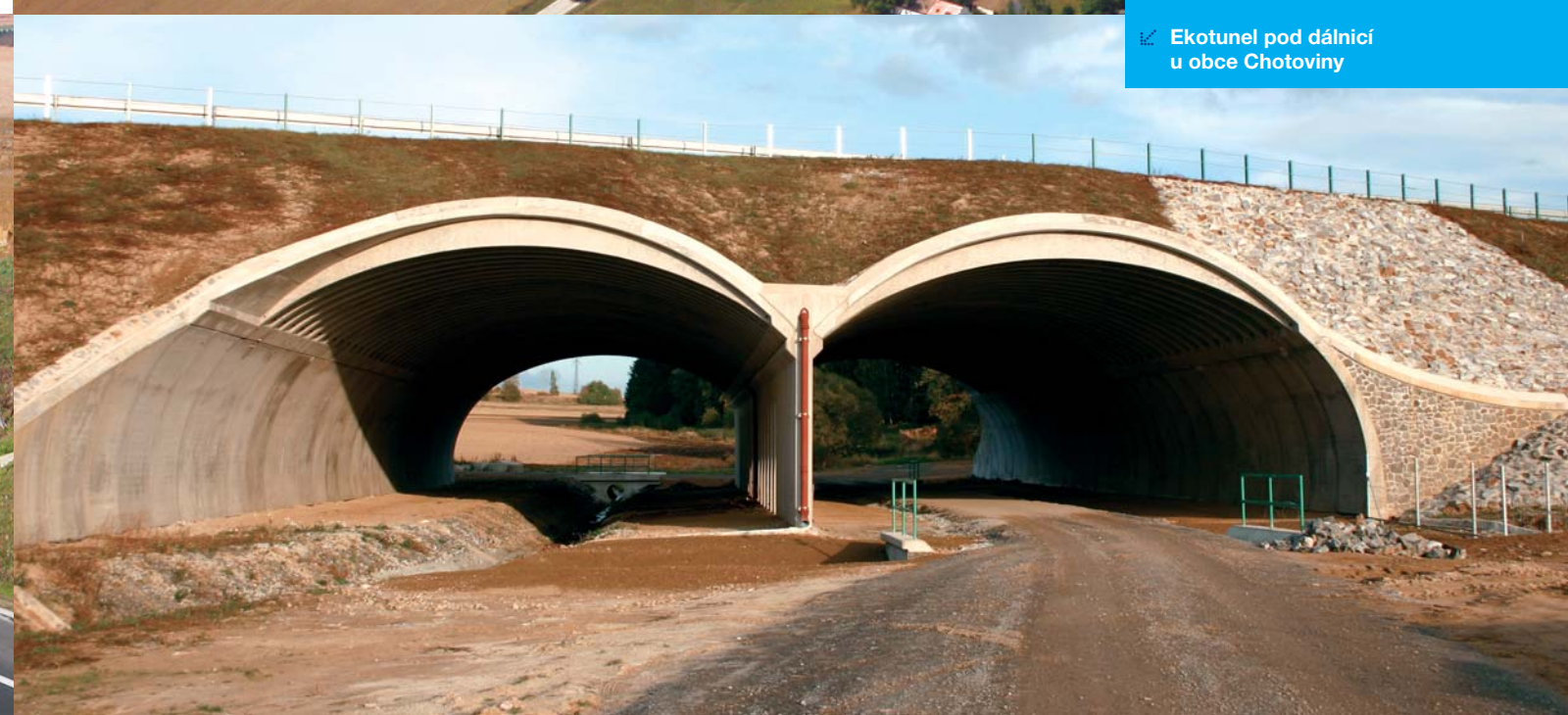
Letecký pohled na rozestavěnou dálnici mezi obcemi Košín a Stoklasná Lhota
