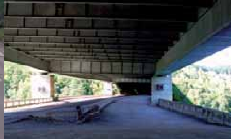
Vnitřní část mostu Píšť
