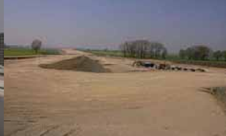
Stavba 0135, křižovatka Hulín D1-R49-R55
