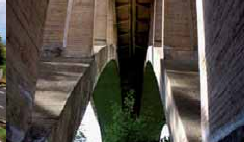
➤ Km 24, původní most (241 m) přes údolí Šmejalky
