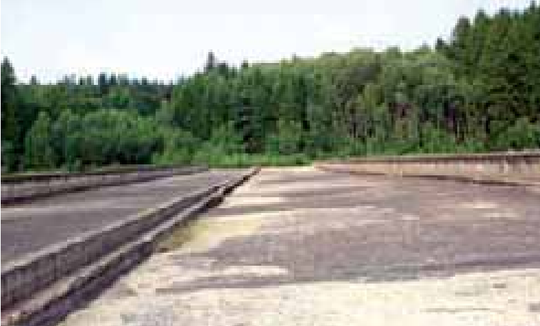
Nepoužitý most přes údolí Sedlického potoka
