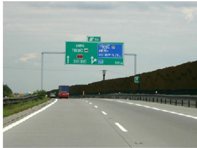
Km 133, směr Brno
