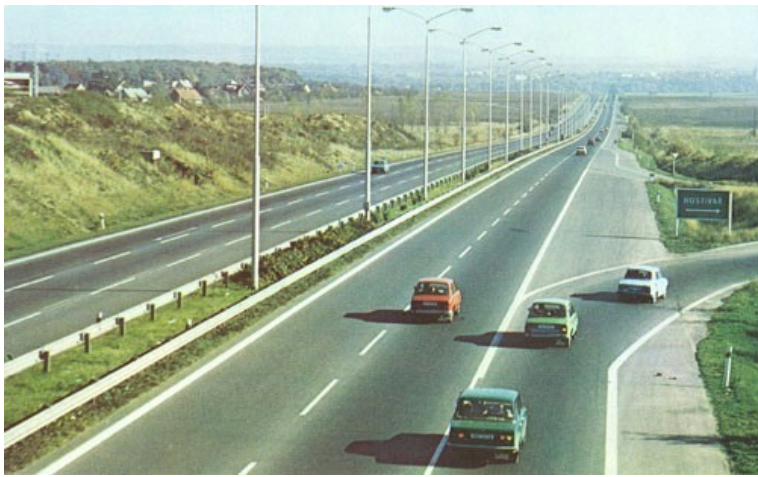
Km 2, směr Brno
