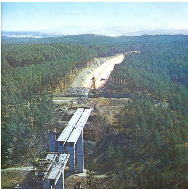
Km 62, směr Brno
