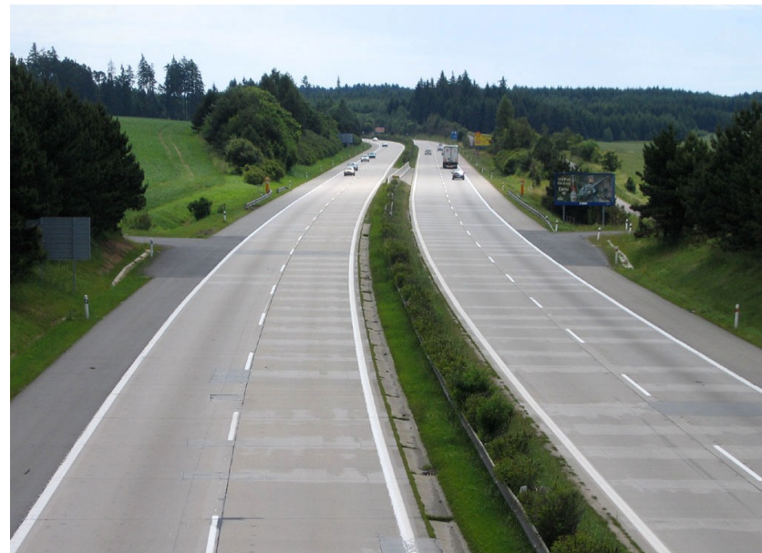
Km 120, směr Brno
