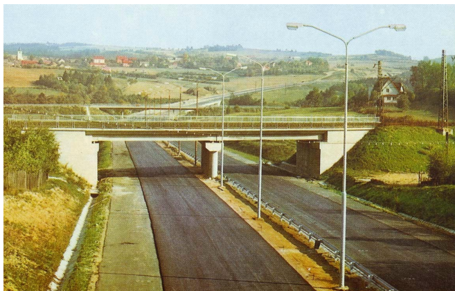
Km 22, směr Brno
