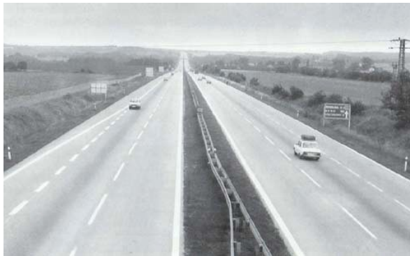
Km 12, směr Brno
