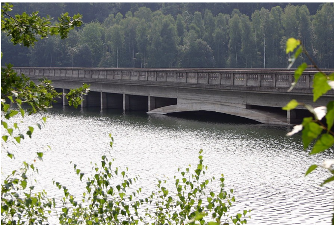
Nepoužitý most přes údolí Sedlického potoka
