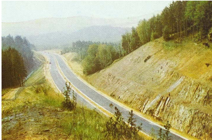
Km 26, směr Brno
