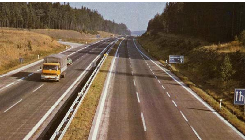
Km 105, směr Brno
