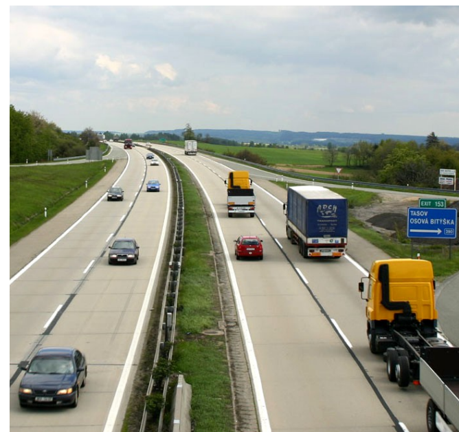
Km 153, směr Brno
